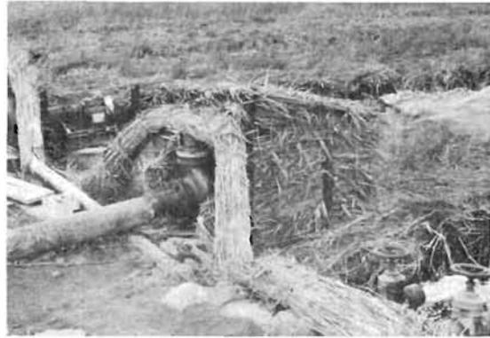
FIG. 55. — Station expérimentale : pompes et tuyaux abrités du soleil.
