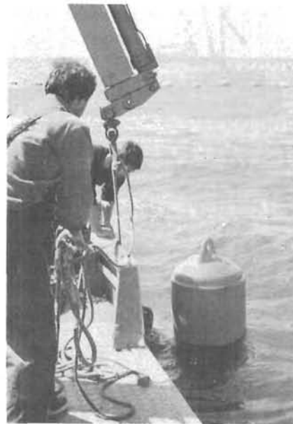
Figure 116 - Maillage d'un amarrage amortisseur sur un corps-mort déjà en place
