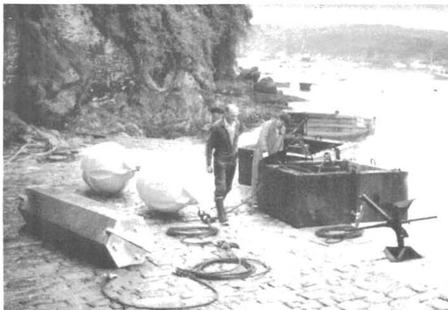
Figure 104 - Ces corps-morts, posés et préparés sur la cale à basse mer, seront amarrés au bateau à marée montante.
