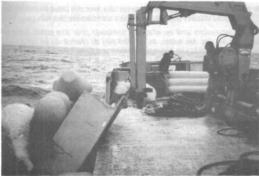
Figure 108 - Poser le corps-mort sur le pont et le pousser avec la grue
