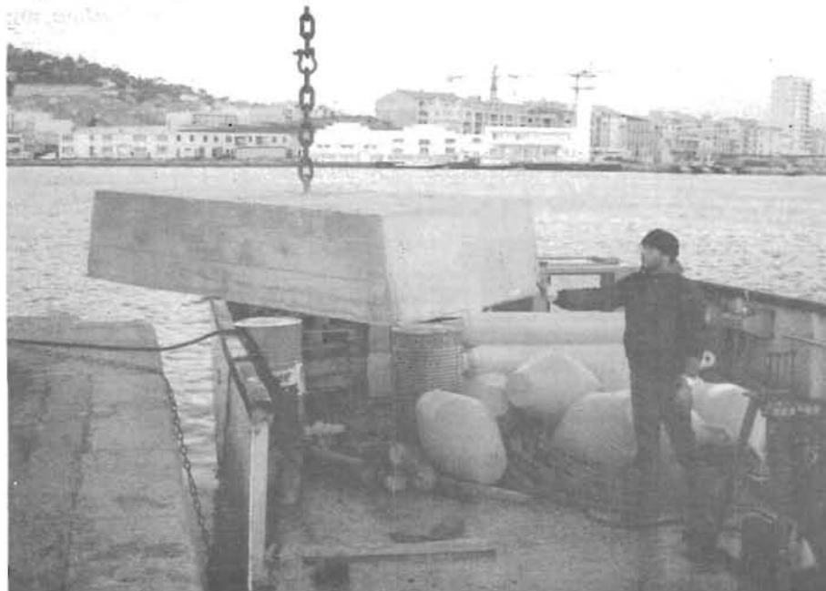
Figure 69 - Corps-mort en béton équipé d'un morceau de chaîne
