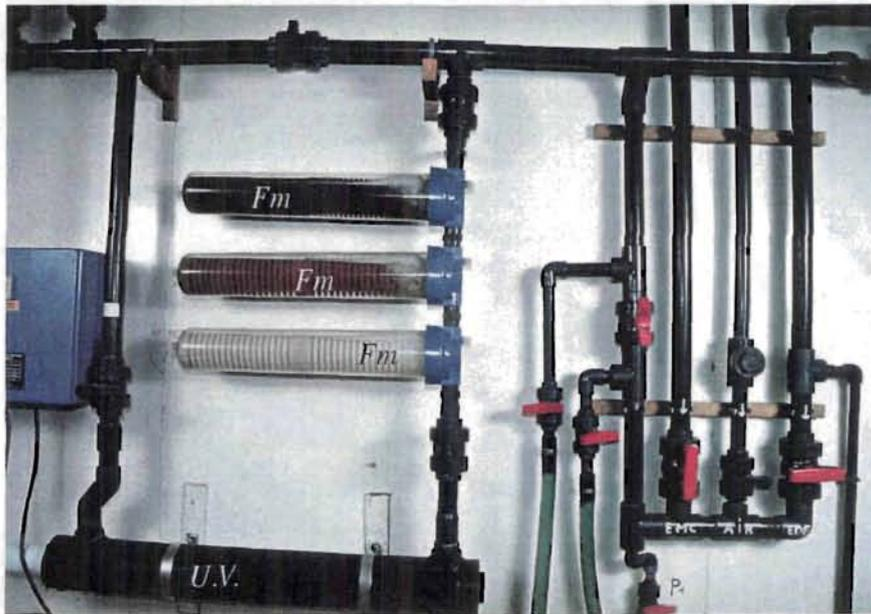
Figure 7. Unité de production de rotifères. Be : bassin d'élevage; Pa : panier de collecte; Fm : filtre mécanique Cuno; U.V. : colonne Ultraviolet.
