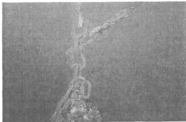
Figure 47 : Montage d'un lest. Vue sous-marine du montage d'un lest en chaîne sur une ligne d'amarrage à 3 filins. Cliché C. Boulay.
