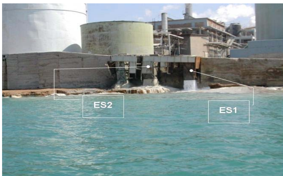
Fig. II.23 : Les 3 principaux effluents de l'usine de Selaata. ES1 déverse de l'eau de refroidissement, ES2 et le 3 ème effluent (à gauche de ES2) déversent les rejets du processus de fabrication.
