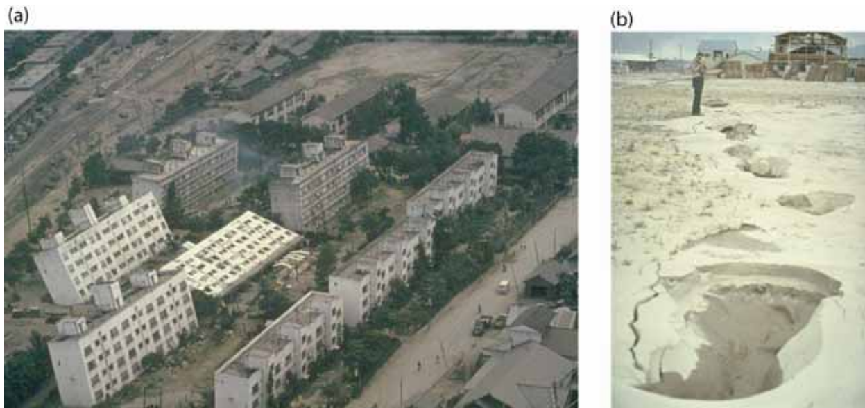
Figure I-21 : Images montrant les désastres causés par la liquéfaction dus au séisme de Niigata 1964 (a) la destruction des bâtiments et (b) liquéfaction du sable avec l'apparition de "sand boils" (source photos : http://www.ce.washington.edu/~liquefaction/html/quakes/niigata/niigata.html ).
