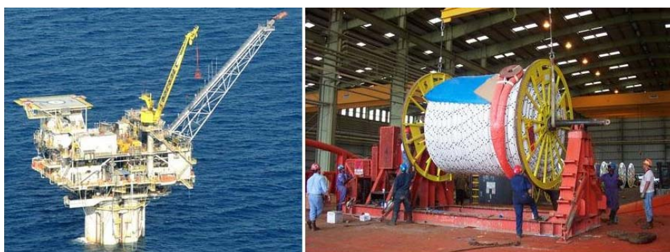
Figure I-7 : A gauche, une plate-forme de l'exploitation Red Hawk ancrée avec des lignes polyester ( www.offshoretechnology.com ) ; à droite, le stockage des lignes en PET avant installation ( www.delmarus.com ).
