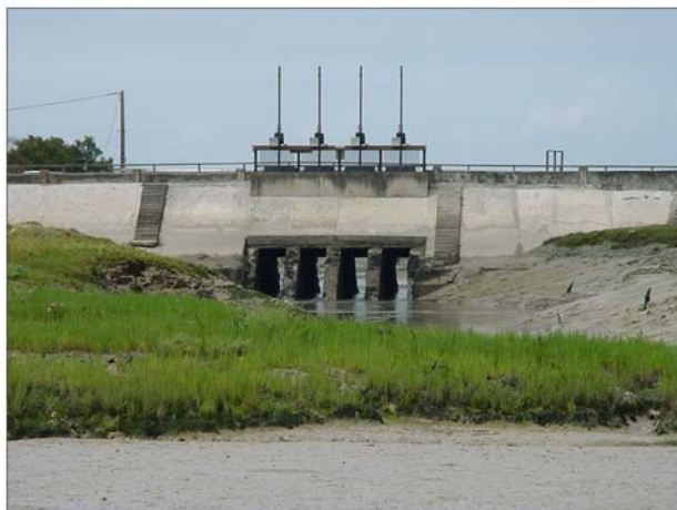
Ouvrage à crémaillère
