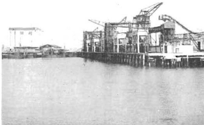
Fig. 74. Les appareils pour la manutention du charbon.
