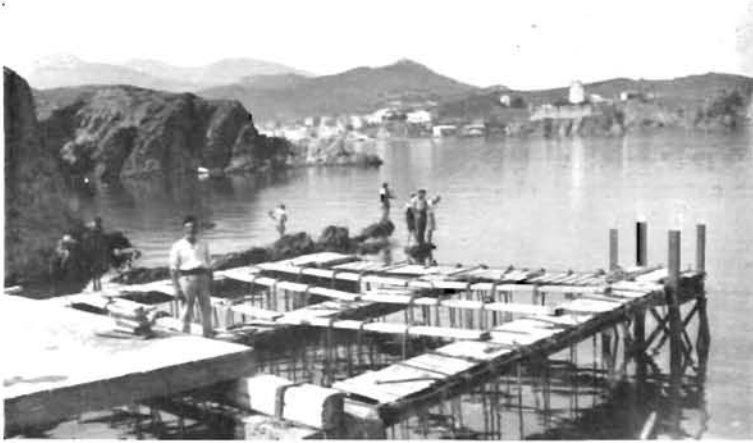
Fig. 98. Port-Vendres. -- Établissement de retrempage.
