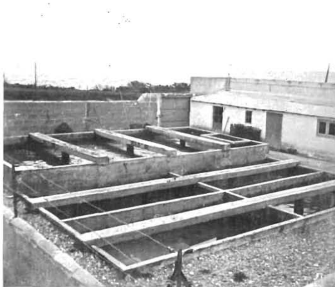
Fig. 97. Sables d'Olonne. -- Établissement d'expédition alimenté par pompe.
