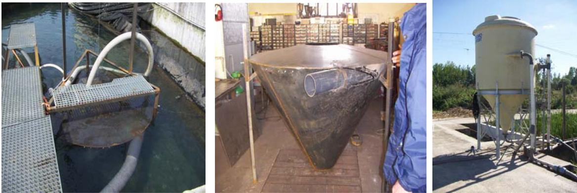
Épaississeur conique (décanteur I) immergé ; épaississeur conique non immergé ; Décanteur II
