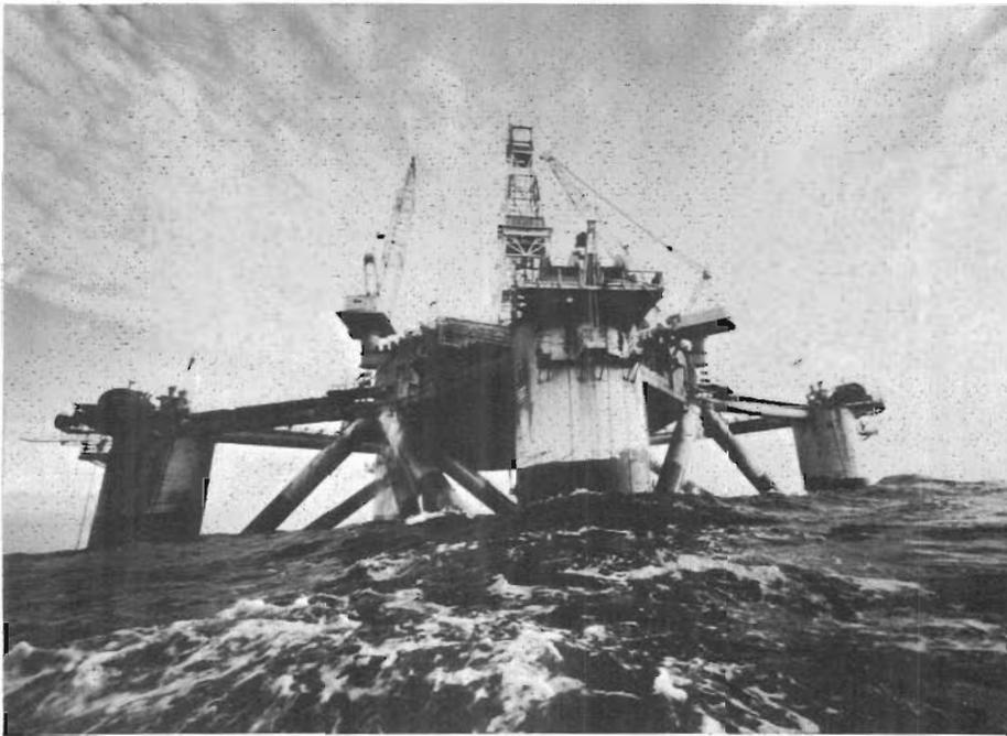
Fig. 6. — Plate-forme semi-submersible « Pentagone ».
