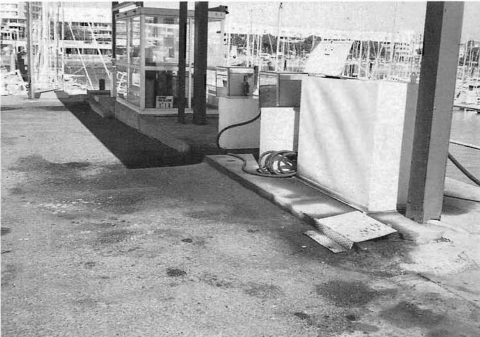
Poste de carburant pour l'avitaillement (Royan - 17)
