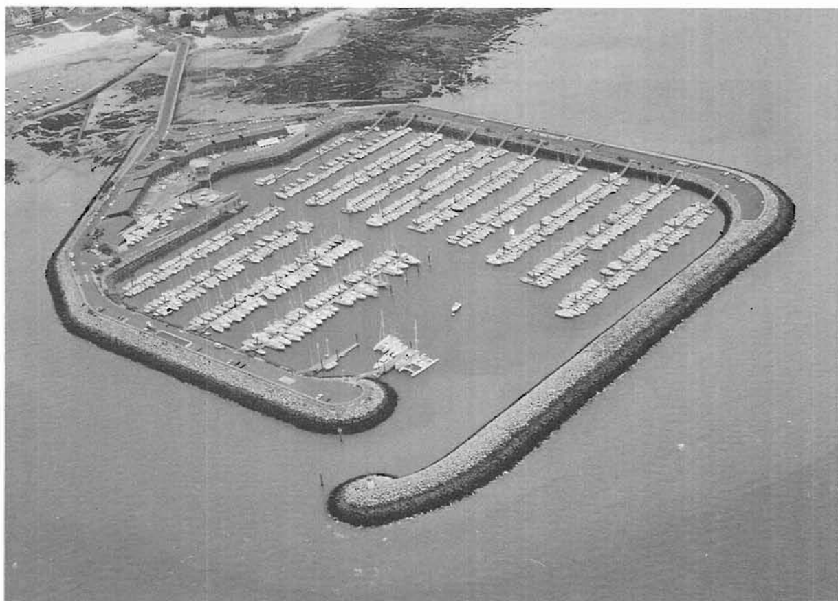
Port en eau profonde de Pornichet (44)
