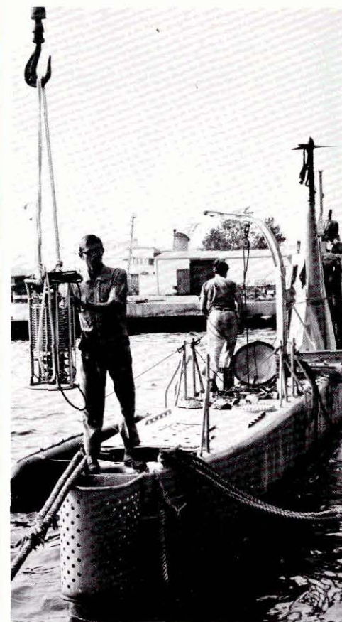
Mise en place du bathymètre différentiel sur le bathyscaphe.
