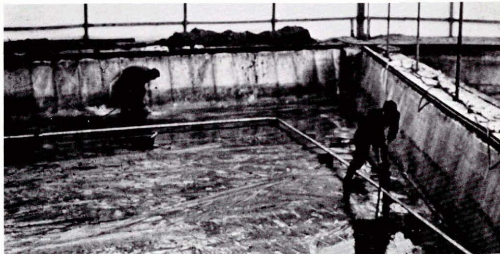
Installations de la Compagnie Générale Transatlantique à QUIBERON - Bassin d'élevage de crevettes.
