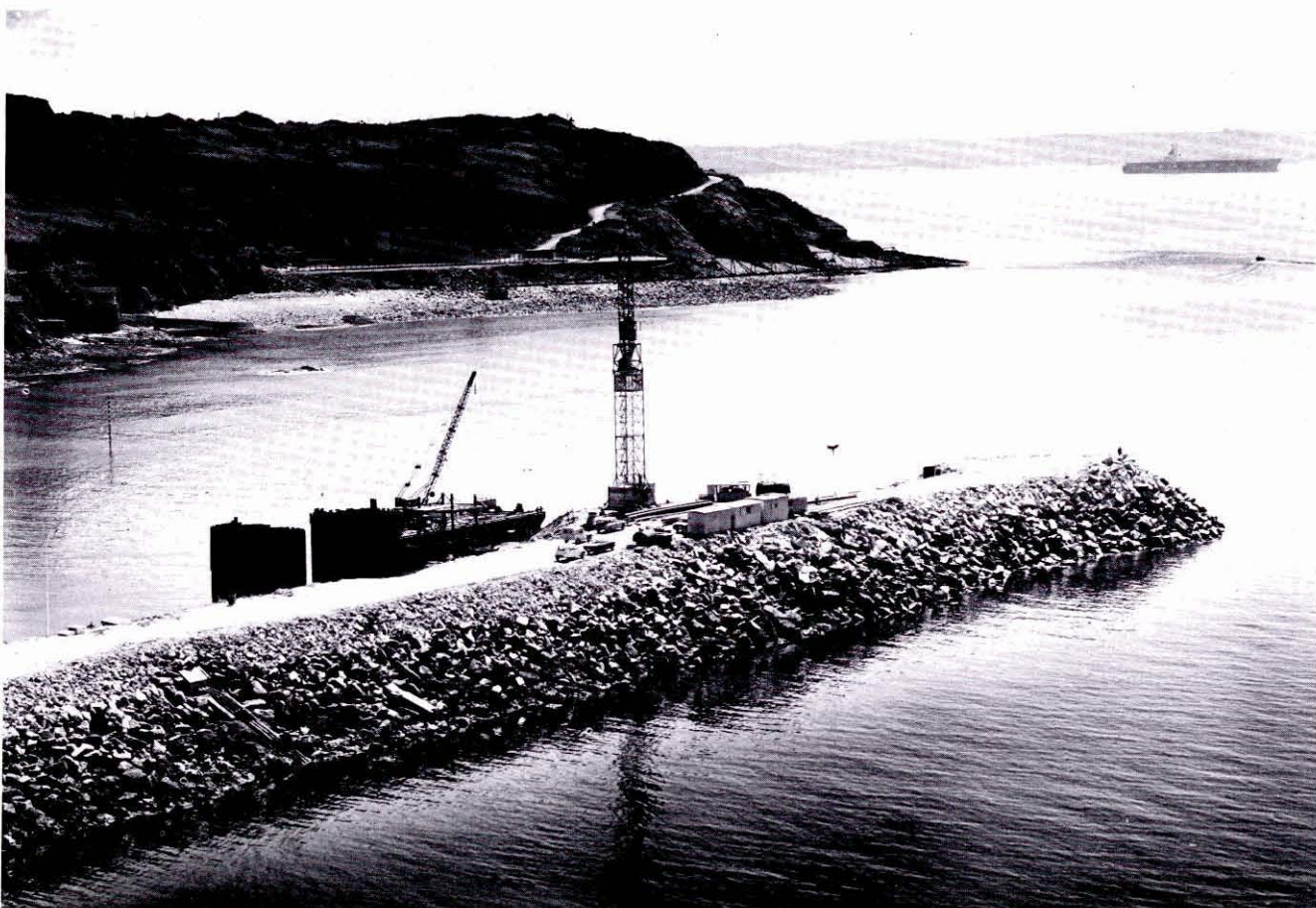
Construction des installations d'escale du môle de l'anse de Sainte-Anne.
