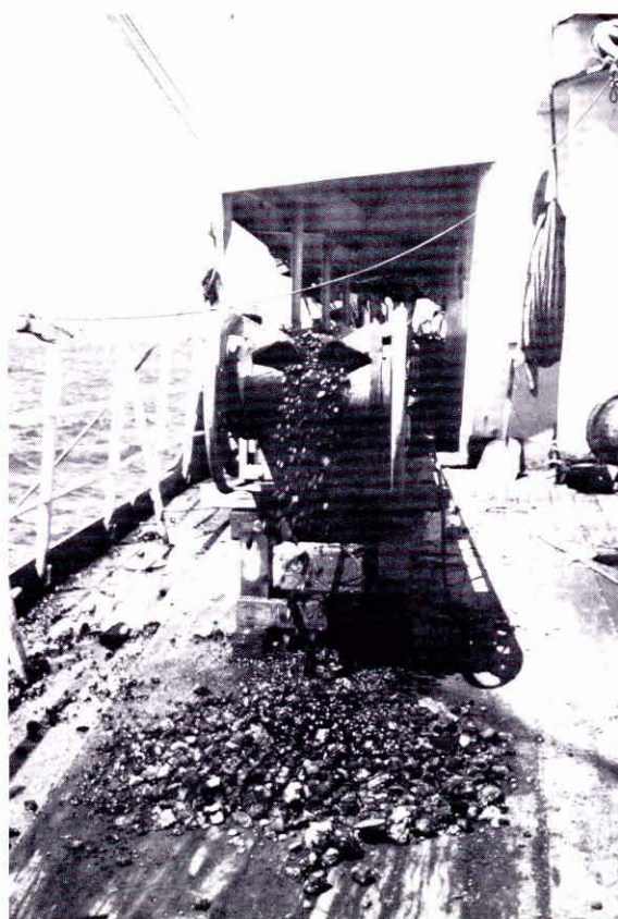
Dragage de nodules polymétalliques.
