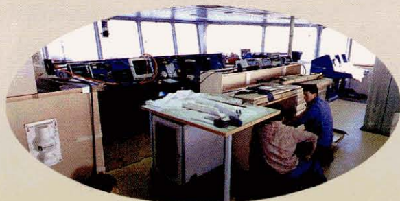
► Passerelle de la Thalassa en cours d'équipement
