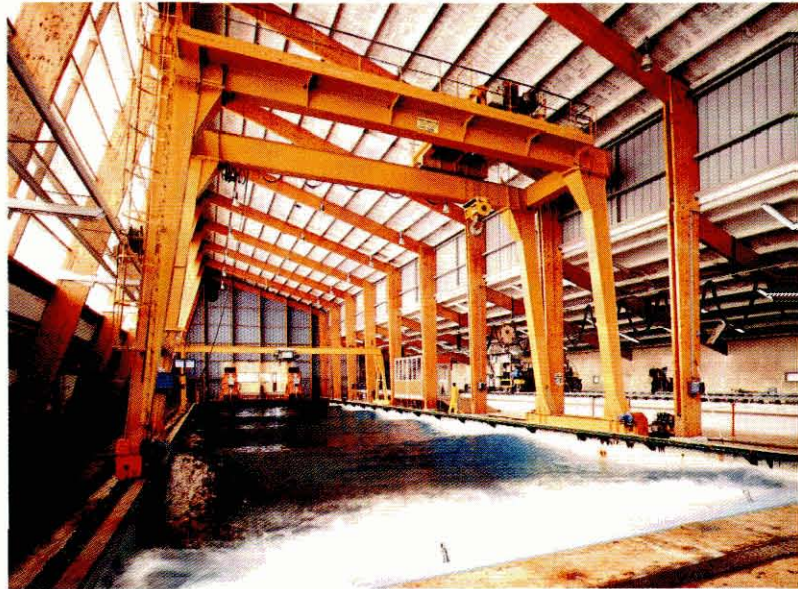
Bassin d'essais profonds à houle à Brest.
