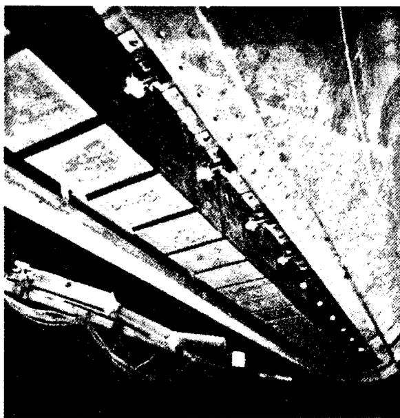
FIG. 2. — Les projecteurs du Sea-Beam pendant le montage sur coque.
