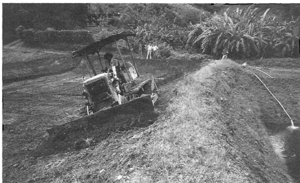
Figure 3.4 : Compactage de digue en Martinique.
