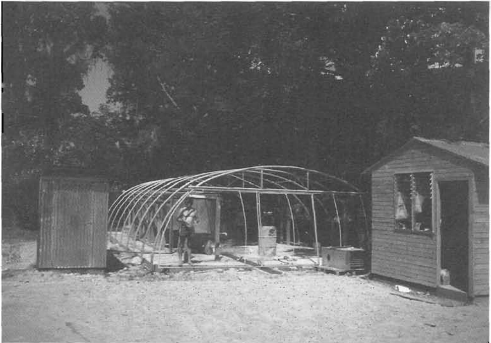
Figure 3.17 : Écloserie provisoire de Guadeloupe en construction (1983).
