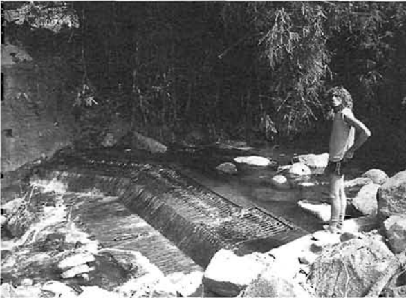
Figure 3.7 : Exemple de captage par seuil de mise en charge pour une ferme de 4 ha en Martinique.
