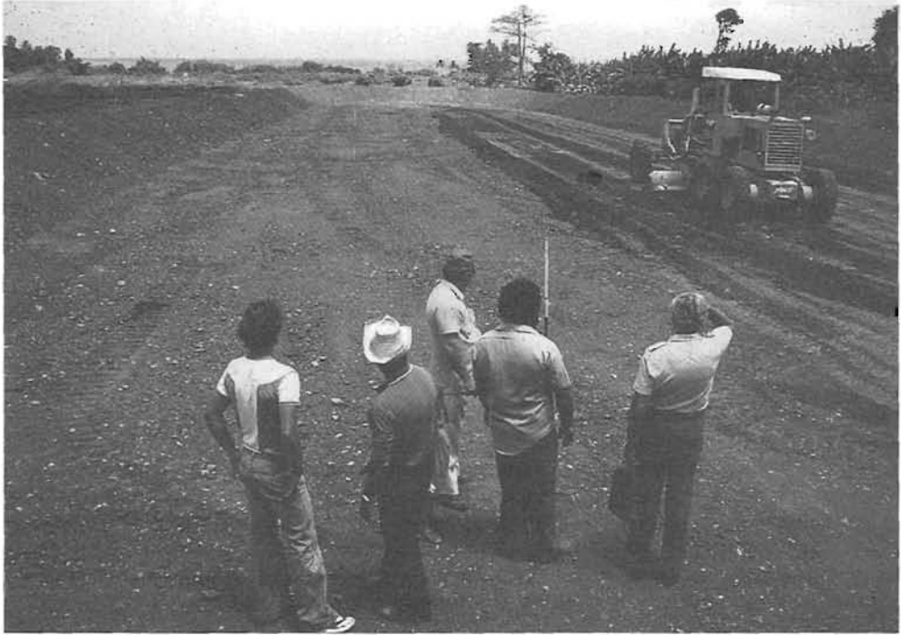
Figure 3.5 : Réglage final de la pente sur un bassin de 3000 m 2 en Guadeloupe.
