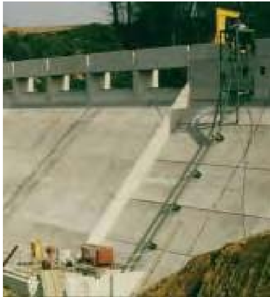
Figure 5. Barrage du Bois Joli (14 m de hauteur) équipé d'une passe-piège de montaison.
