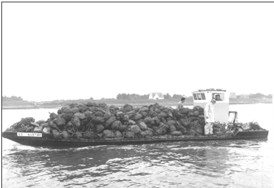
Photo n°2 – Pose de collecteurs en baie de Quiberon (1978)
