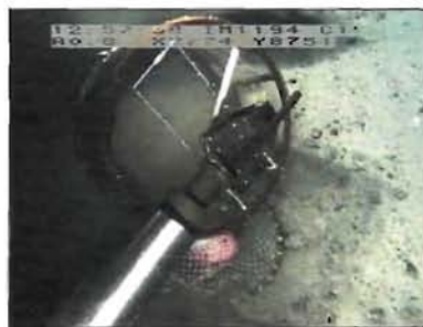
_imag039.tif Positionnement de l'enceinte de confinement
