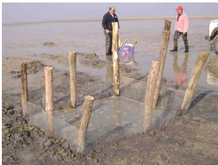
Figure 21 : Mise en place du grillage pour délimiter le périmètre extérieur de la zone.
