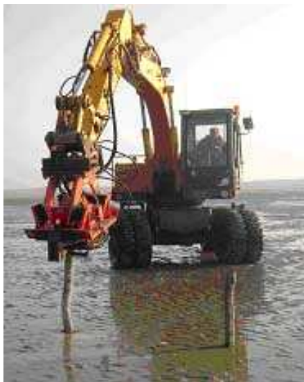
Figure 20 : Mise en place des pieux de mytiliculture à l'aide d'une grue.
