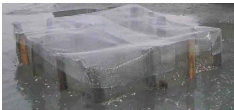
Figure 23 : Fermeture de la structure par du grillage galvanisé à maille carrée.
