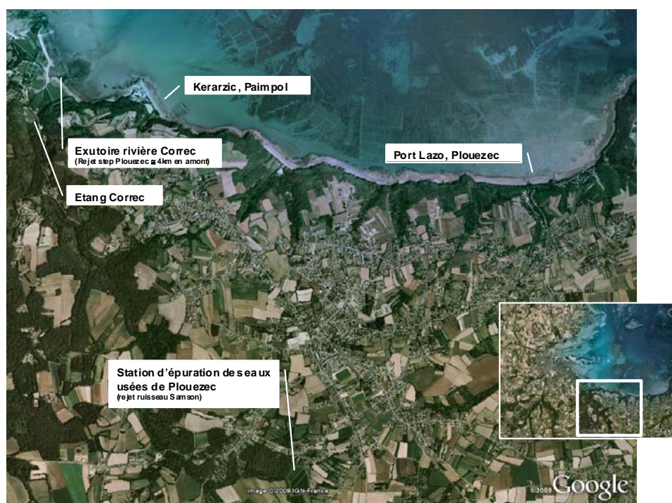
Figure 16 : Localisation de la station de traitement des eaux usées de la commune de Plouézec.
