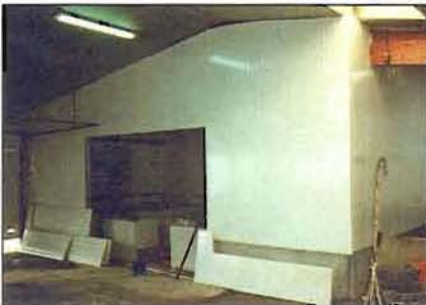
Figure 13 : isolation du pilote purification
