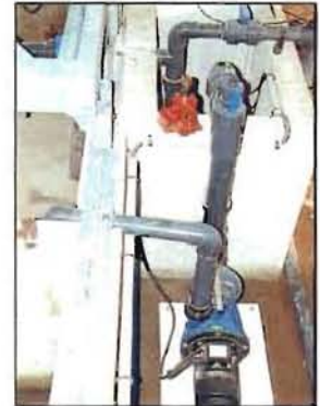
Figure 12 : pompes de recyclage, vidange et aération sur le bassin purification (idem bassin témoin)
