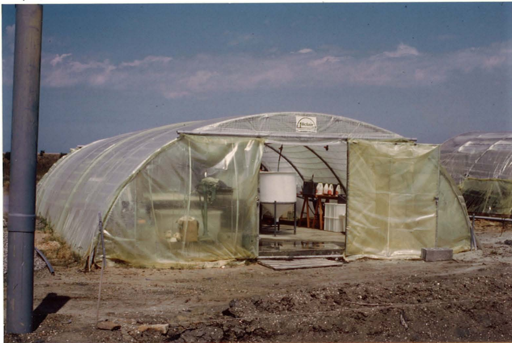
Fig. 8.- Une vue de la station de Bouin. La serre où ont été menées les opérations d'ensemencement a été partiellement recouverte (sur le côté sud et le côté est) d'une toile en Rhovyl blanche qui abaisse l'éclaircissement et la température internes. Les portes nord et sud ont dû être maintenues constamment ouvertes. L'alimentation en eau est assurée par une prise disposée dans le canal latéral.
