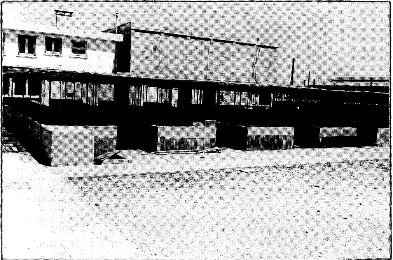
Fig. 50 - Bassins de la station du "Dauphin" à Sète "Pointe Courte", pour traitement des mollusques en eau purifiée.
