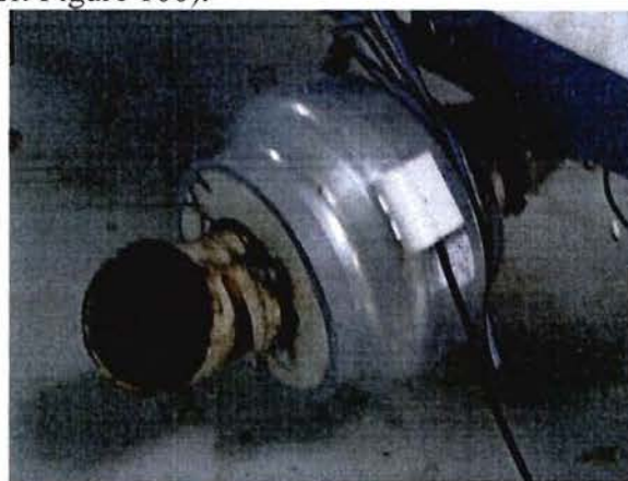
Figure 100 – Turbine d'extraction des fumées
