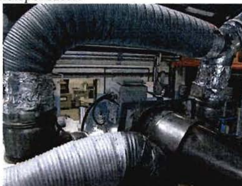
Figure 99 – Turbine de tirage du générateur de fumée
