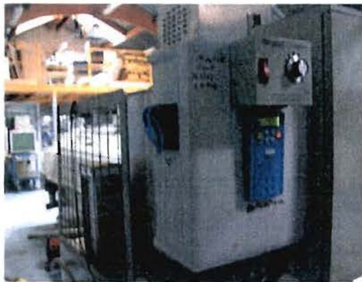
Figure 98 – Installation d'un variateur sur la trémie d'alimentation en copeaux
