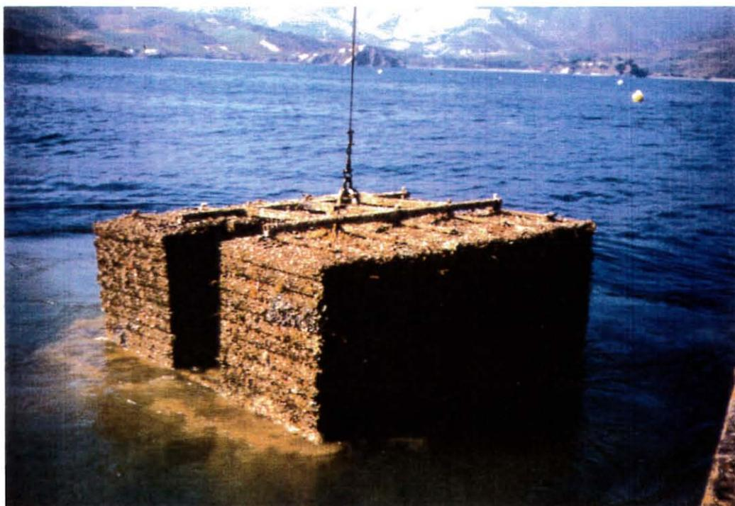
Photo 2 - Renforcement de ce système à l'aide d'un cadre métallique solidaire de la galerie centrale.
