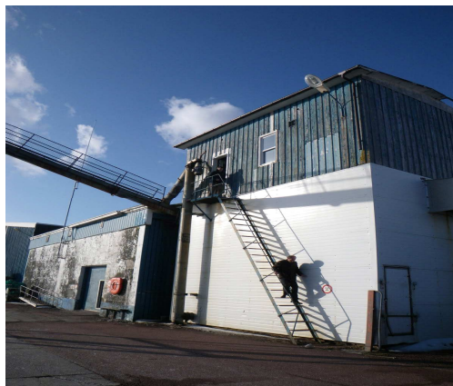
Figure 17: Silo à glace et fabrique de glace existants
