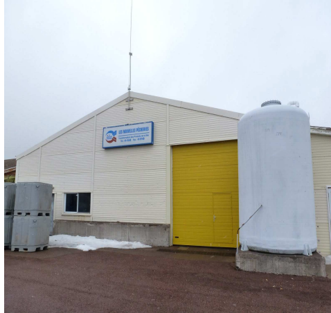
Figure 14 : Bâtiment Nouvelles Pêcheries à Saint Pierre
