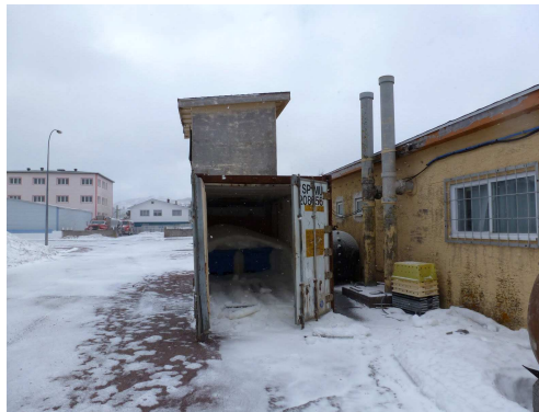
Figure 15 : Fabrique de glace existante sur container
