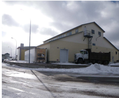
Figure 9: Bâtiment de la SNPM à Miquelon
