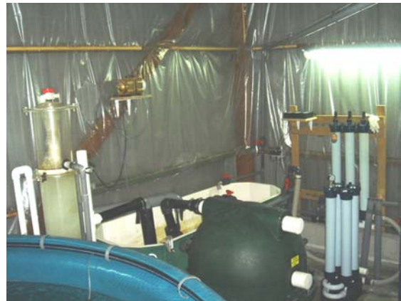
Vue générale du système centralisé de traitement de l'eau recirculée : écumeur, filtre biologique, filtres 10 microns et UV
