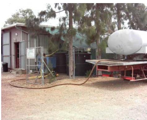
Alimentation en eau de mer brute des cuves de traitement
