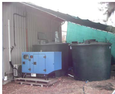
Les 2 cuves fermées de 5 m 3 utilisées pour le traitement de l'eau de mer brute
