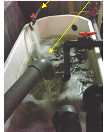
Vue du bac tampon avec les arrivées d'eau de mer neuve en provenance de l'extérieur et usée en provenance des bacs
