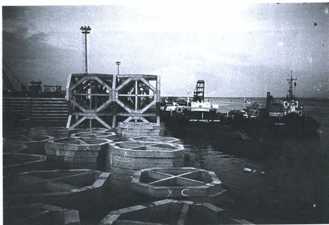
Photo 6 : Stockage de récifs de production avant immersion : grand modèle
