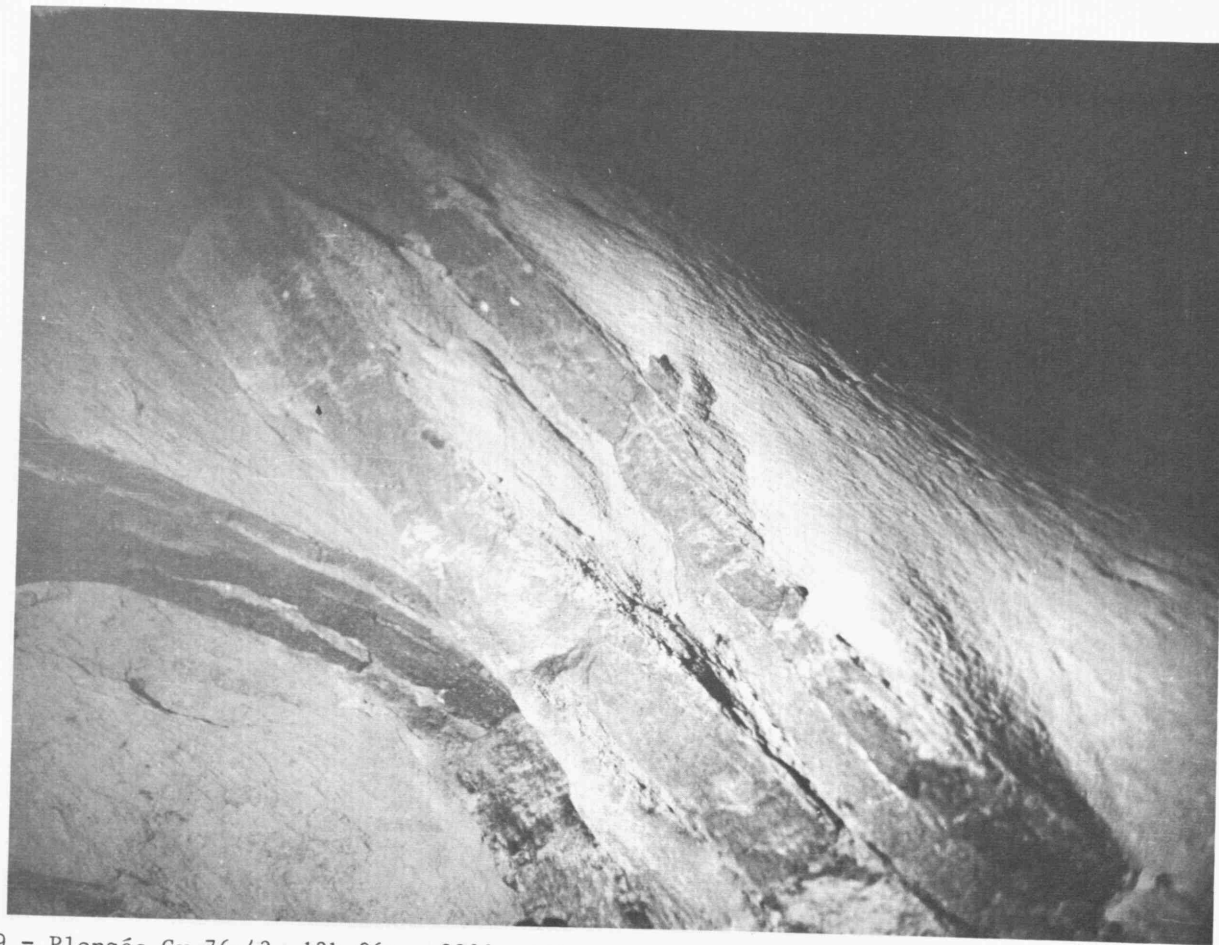
9 - Plongée Cy 76-43. 13h 06mn. 2200 m. Panneau gréseux basculé (N 270, 45°S). Versant N du canyon des Stoechades.
