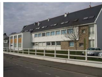
Station de la Trinité sur Mer
