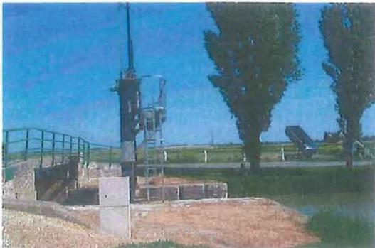
**Figure 9 : Vue d'une vanne, permettant d'alimenter le marais agricole, en amont de l'écluse de Beaugeay**
