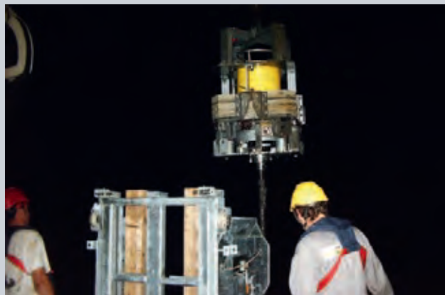
Opération de mise à l'eau et de récupération du piézomètre
