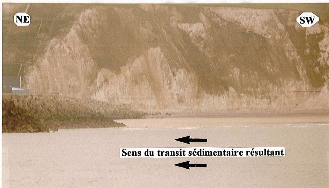
Fig.15 : Photographie du piégeage de sédiments à l'Ouest des jetées de la centrale de Penly.
