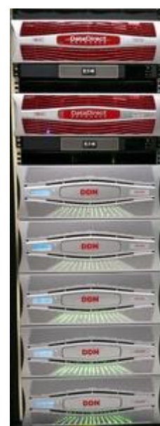
Figure 7-6 : contrôleurs et baies disques des espaces lustre
