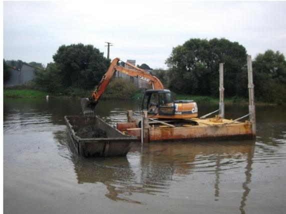
Figure 2 : Dispositif de dragage.
