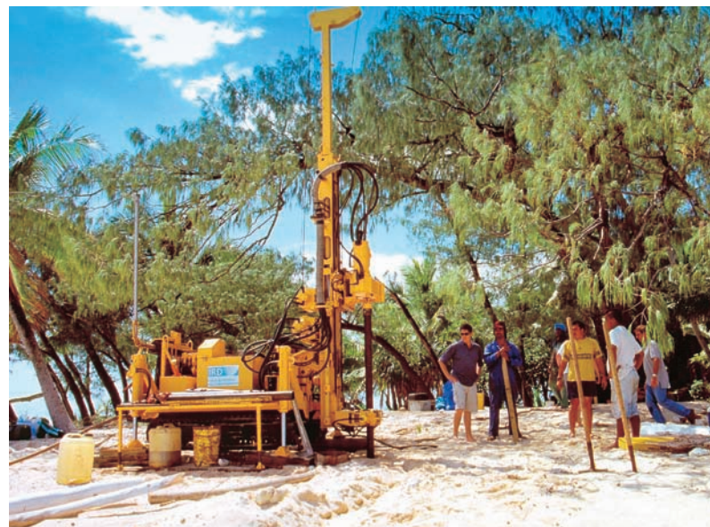
Forage du récif-barrière, îlot Bayes, côte est de la Grande Terre (2002). © IRD/G. Cabioch
