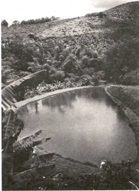
Photo 4. Bassin de grossissement de 1 700 m 2 au LORRAIN (MARTINIQUE).
