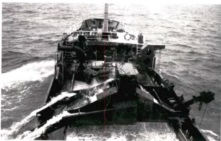
6c - Le sablier en activité, utilisant le crible inverse.
