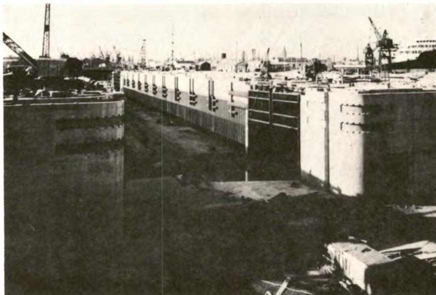
Figure 4 - L'Ecluse Trystram (Dunkerque) en 1955 avant sa mise en eau. Les bajoyers en palplanches métalliques et les portes sont équipés d'une protection cathodique. Les compartiments étanches des portes sont remplis d'eau douce et passivés par un inhibiteur. On remarque l'anode en acier de 200 t posée sur le radier revêtu d'asphalte.
