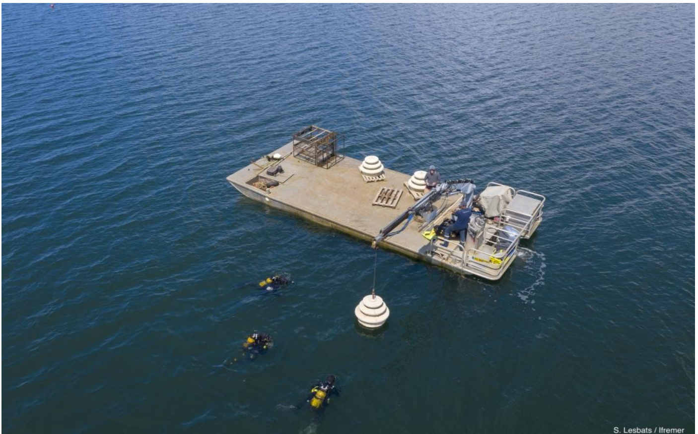
Photo 3 : Restauration active par implantation de récifs adaptés : Déploiement de récifs en béton coquillier sur le banc du Roz en rade de Brest. Le travail se fait par grutage depuis une barge avec assistance par des plongeurs professionnels pour un positionnement sur le fond (crédits : S. Lesbats / Ifremer)
