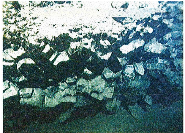
2. Coulée massive prismée vue du dessus
