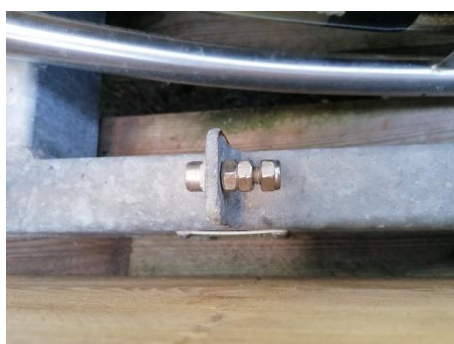
Figure 19 : Système de fixation vis/écrou.
