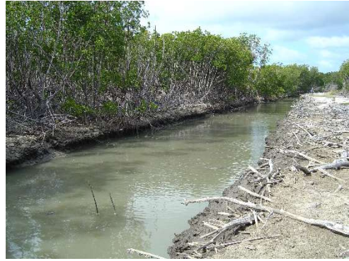
Photographie VIII-1. Canal creusé dans la mangrove pour évacuer les effluents sur le site de la ferme La Sodacal.
