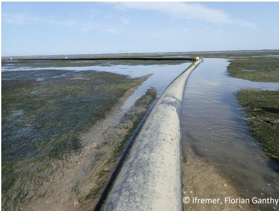
Figure 17 : Conduite de refoulement reposant sur l'herbier
