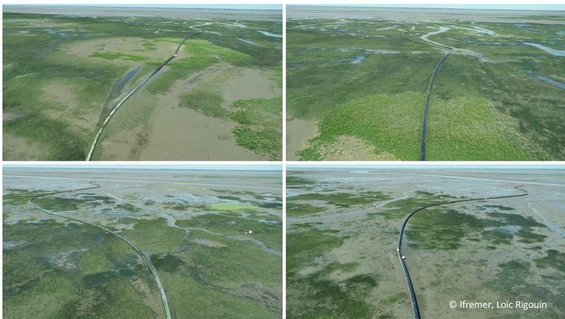
Figure 19 : Extrait des vidéos montrant les conduites de refoulement reposant en partie sur de l'herbier.
