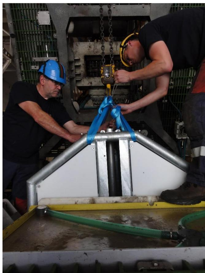
Les garcettes supérieures sont glissées dans Penfeld. Elles permettent de soulever le tube de guidage pour visualiser le passage de la pointe TIPS.
