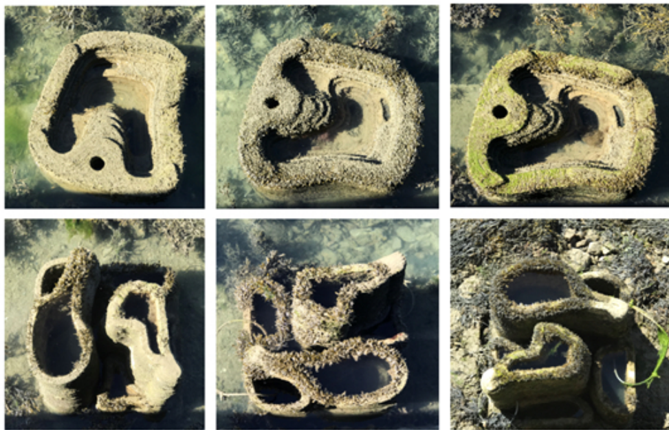
Figure 8. Cas d'étude de réhabilitation écologique dans le port-Haliguen (Quiberon) : installation de différents prototypes de cuvettes à marée avec une complexité 3D importante. [Source © Seaboost – M. Lapinski]
